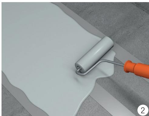
Tragen Sie die erste Schicht von SEALPUR SILAN TX (ca. 1,5 - 2,0 kg/m<sup>2</sup>).
